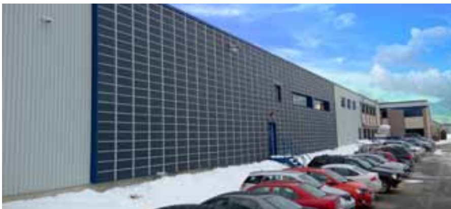
Anläggningen i Magog, Kanada, har under 2012 investerat i en så kallad solvägg. Tack vare den nya tekniken har anläggningens gasförbrukning minskat med närmare 20 procent.
